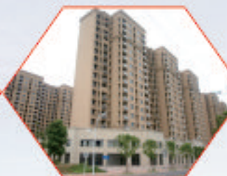
新华山矿棚户区改造项目
