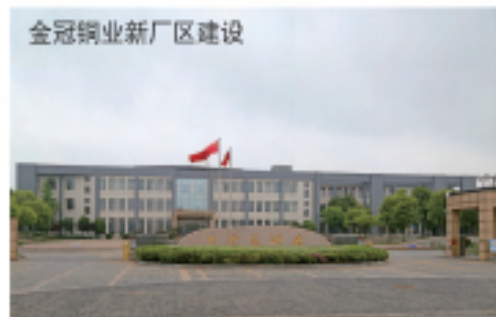
金冠铜业新厂区建设
