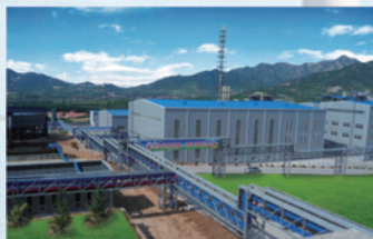
山东招金金矿氰化尾渣资源综合利用示范工程
