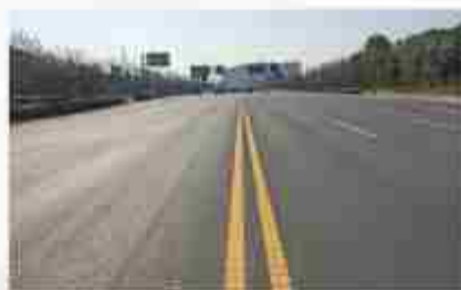
铜陵市九华山大道道路工程
