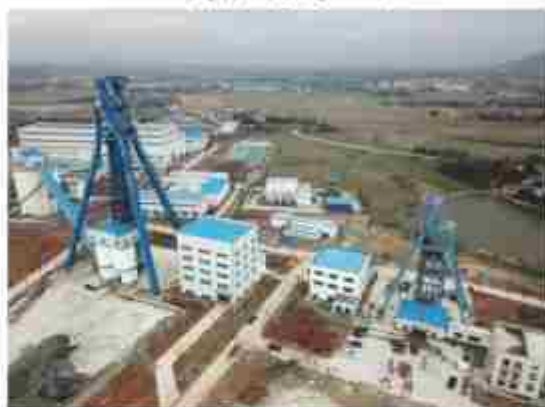
沙漠铜矿主井工程
