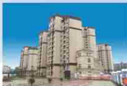
扫把沟二期棚户区改造1#4#5#楼工程
